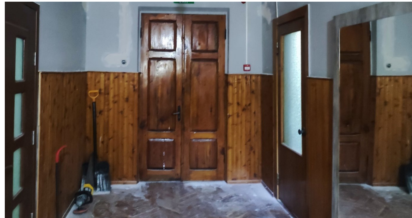
Reparația sistemului de electricitate, sistemului de încălzire, vopsirea pereților - B2L Bălți
