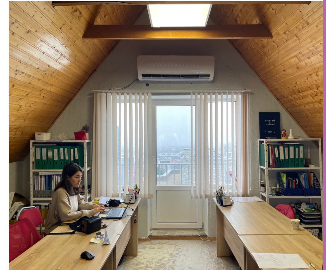
Instalarea condiționerelor - Grace House Chișinău
